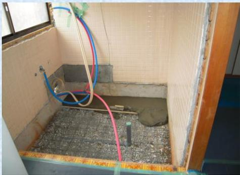
【土間コンクリート施工】砂利ワイヤーメッシュを敷き、土間コンクリートを打設します。
