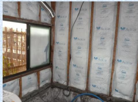
【断熱材施工】内部には、保温のためしっかりと断熱材を入れます。
