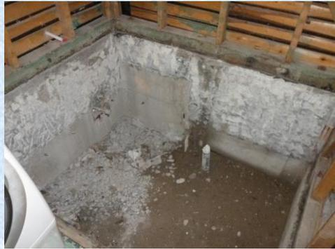
【浴室解体後】ここまで綺麗に解体し、新設するシステムバスの規定の深さまで掘削します。
