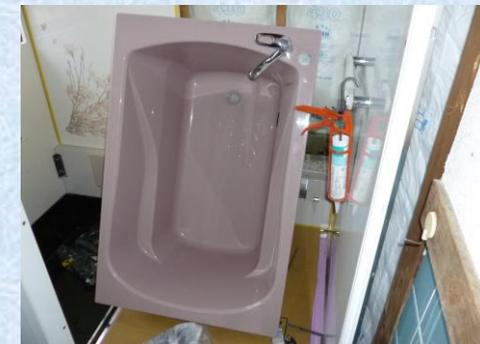
【システムバス組立据付】床据付・壁パネル組み上がってから鋳物浴槽を設置します。
