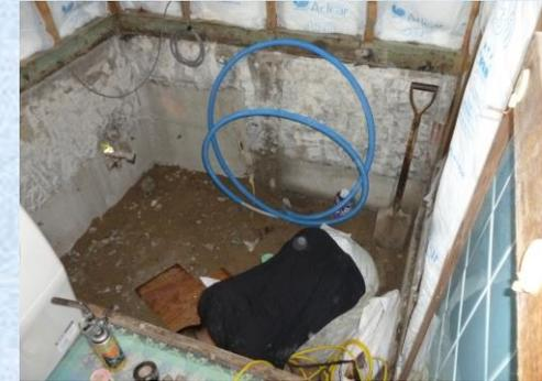
【給排水設備】解体後新しい排水給水位置に合わせて配管を行います。
