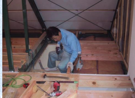
丁寧に床組みがなされています
