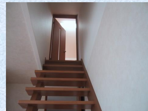
二階の部屋を開口し、扉を取付け、 屋根裏部屋へ行きます
