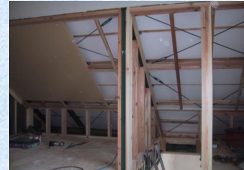
壁・天井に下地を貼ります この上にきれいにクロスを貼ります
