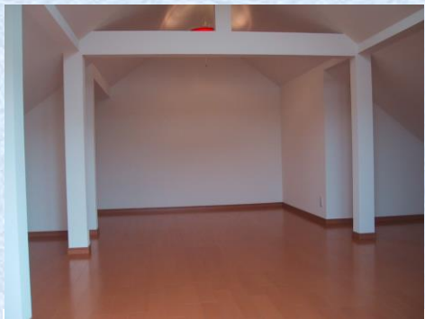
柱と梁を入れ、強度を確保します
